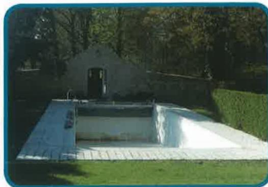
*Les 2 photos ci-dessus montrent clairement l'apparition de taches de sulfures métalliques, à la surface de la membrane en PVC-P équipant ces deux piscines.*
