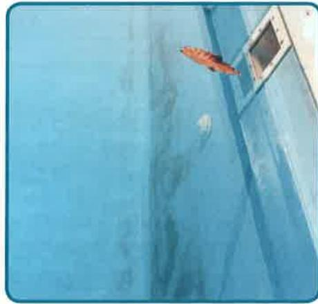
Migration, au travers de la membrane en PVC-P, des pigments contenus dans les panneaux d'une piscine industrialisée.
