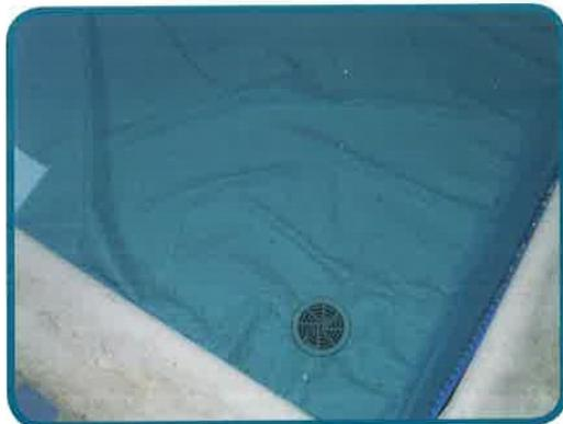
*Formation de plis, au voisinage de la bonde de fond, trahissant la présence d'eau sous le liner.*
